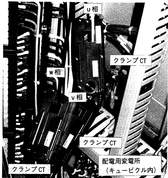
図3 クランプCT (9270)設置様子の写真
