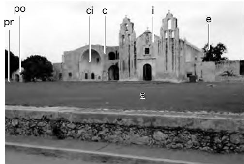
【写真3】 教会施設全体
