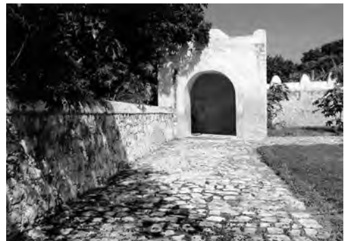
【写真8】 マニに残存する一つの柱廊と欄干 (写真左端部分)
